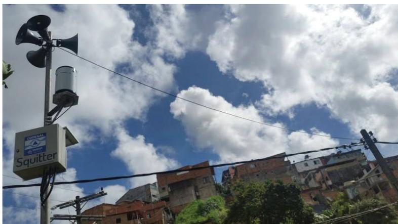
Imagem 3 – Pluviômetro e sirene instalados em área de risco em Salvador.
